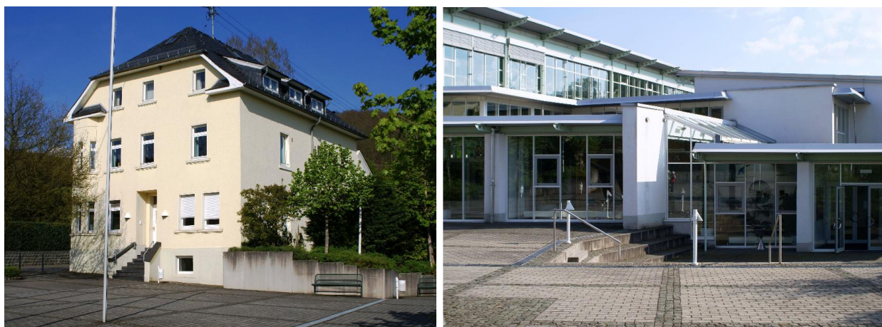
Das Wohnheim (links) und das Leistungszentrum mit Gerätehalle und Sporthalle (rechts)
